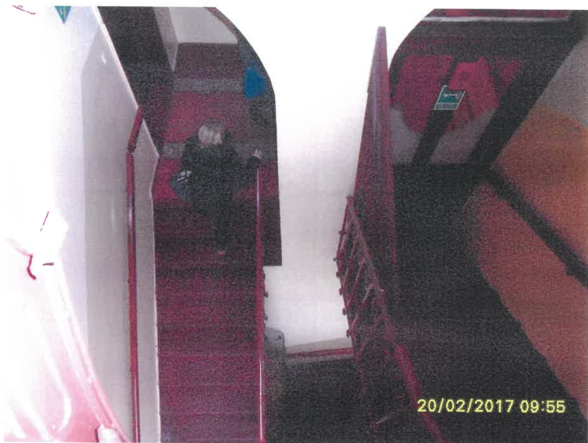
Klatka schodowa K 1 zamknięta drzwiami bez odporności ogniowej .
