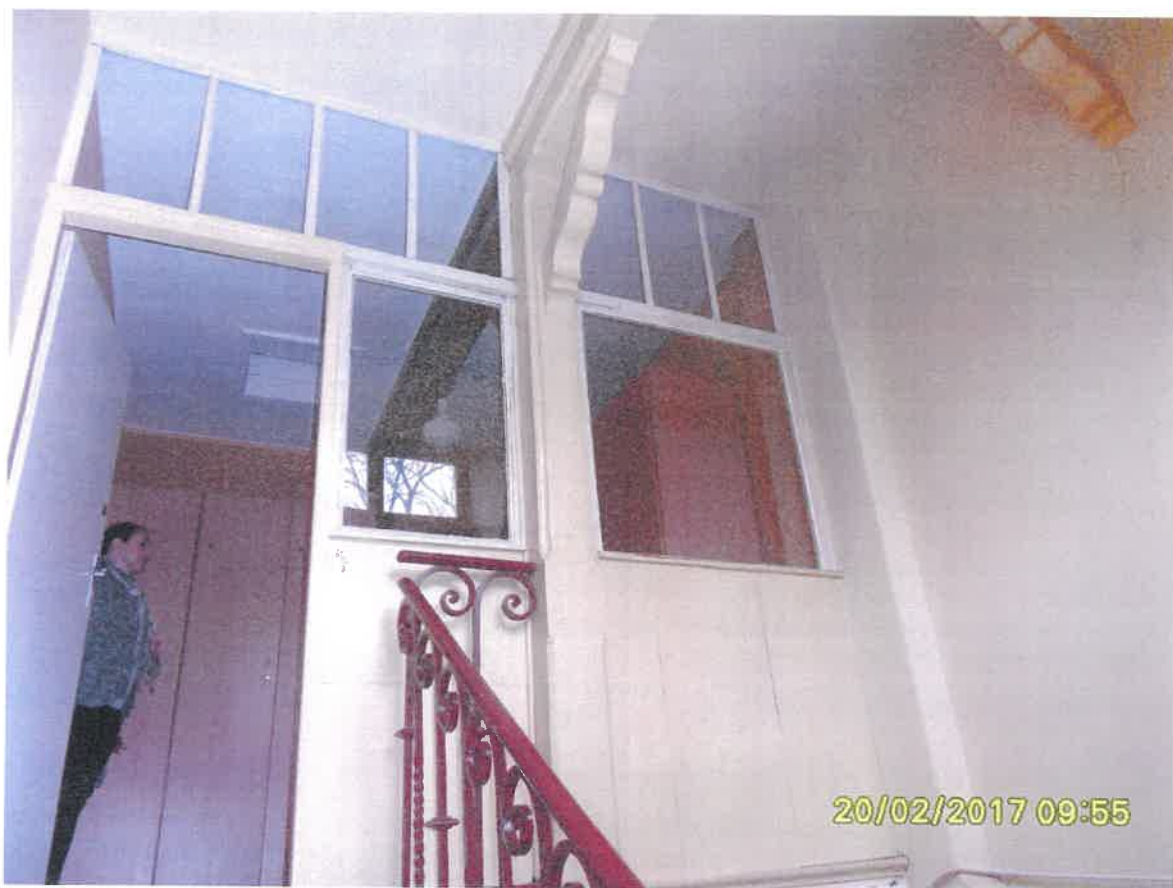
Zamknięcie klatki schodowej K 1 obudową z materiałów palnych i drzwiami bez odporności ogniowej.
