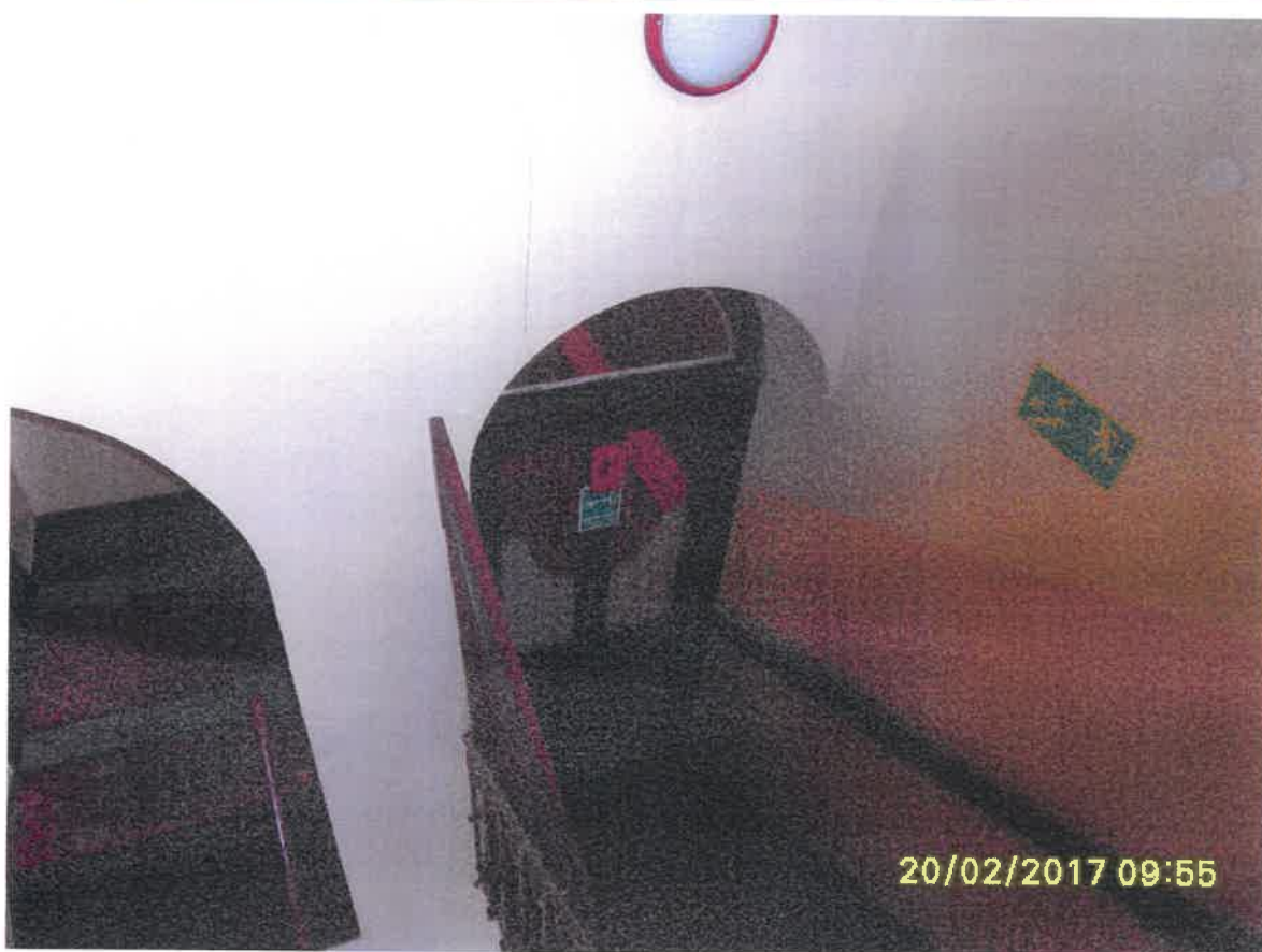
Klatka schodowa K -1 z zabiegowym układem biegu schodowego i nie normatywnymi spocznikami.
