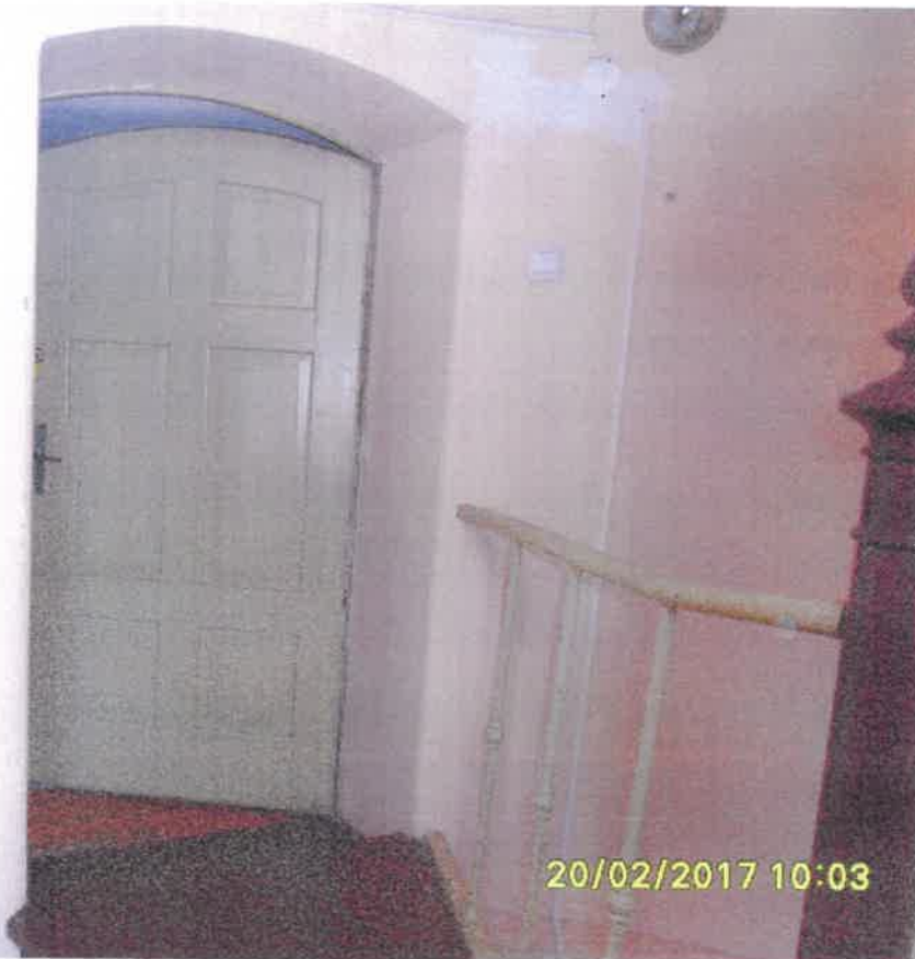
Zamknięcie klatki schodowej K 2 , drzwiami bez odporności ogniowej .
