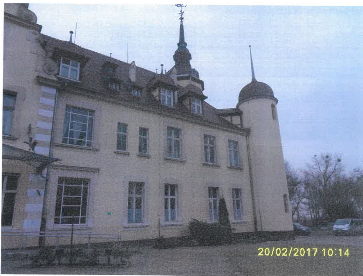
Przekrycie dachu wykonane z dachówki ceramicznej .
