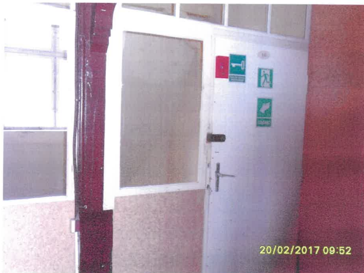
Klatka schodowa K 1 zamknięta drzwiami bez odporności ogniowej .
