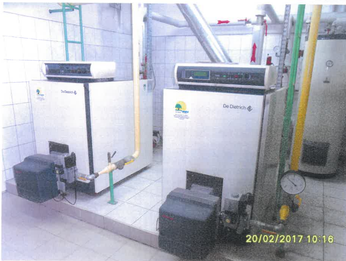
Kotłownia o mocy pojedynczego kotła ok. 65 kW , zlokalizowana w piwnicy z wejściem od zewnątrz .
