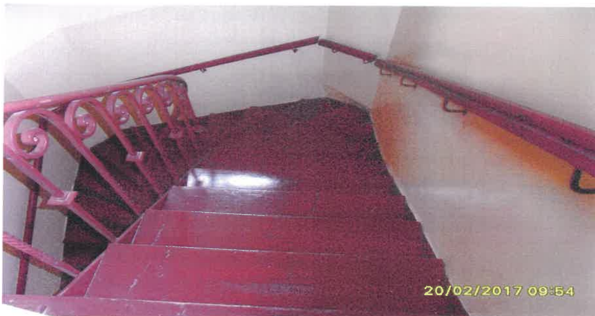
Klatka schodowa K-1 o konstrukcji stalowej i stopnicach drewnianych .
