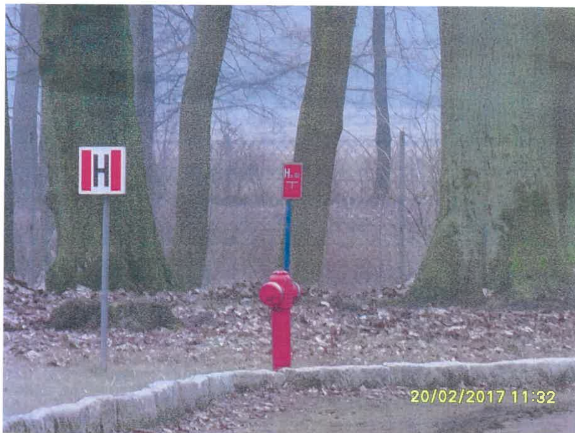
Hydrant zamontowany na sieci wodociągowej.
