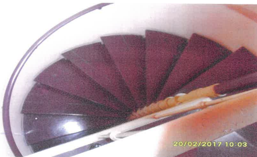
Klatka schodowa K-3 ze schodami zabiegowymi o konstrukcji stalowej .
