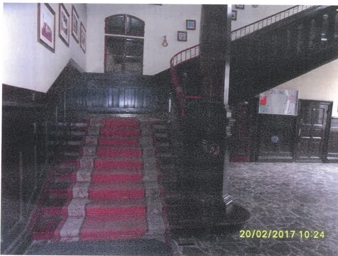
Główna klatka schodowa K – 2 o konstrukcji drewnianej łącząca parter i I piętro .
