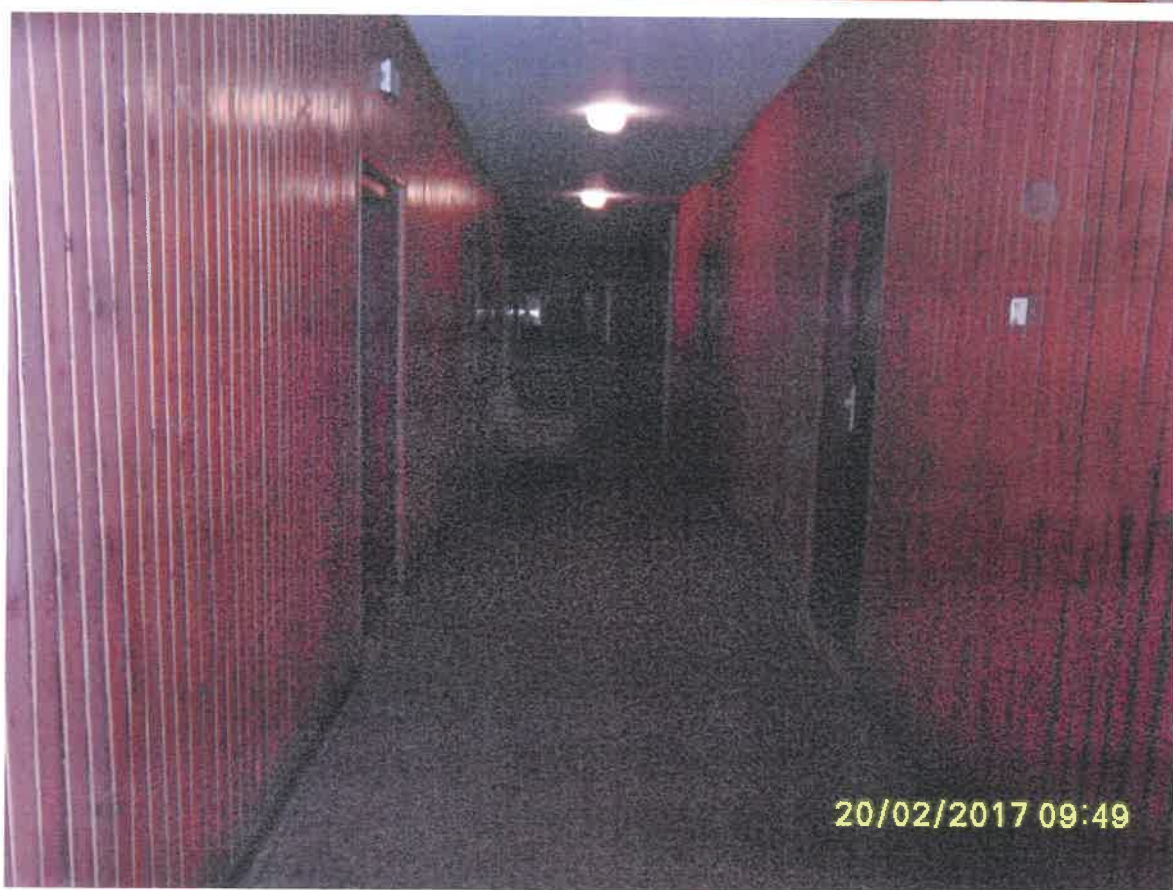
Wystrój korytarza i schodów na poddasze wykonany z materiałów palnych.
